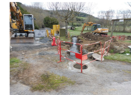
Mise en place des réseaux souterrains de la future station près du Landas
