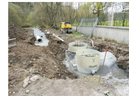
Installations techniques pour le poste de refoulement de la rue de la Foun dal Loc
